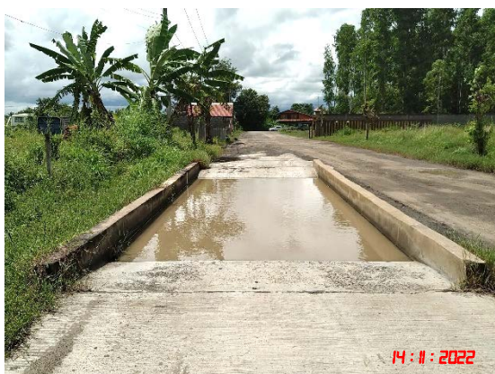
รูปที่ 8 ลานล้างล้อก่อนออกสู่ทางหลวงหมายเลข บร.3001
