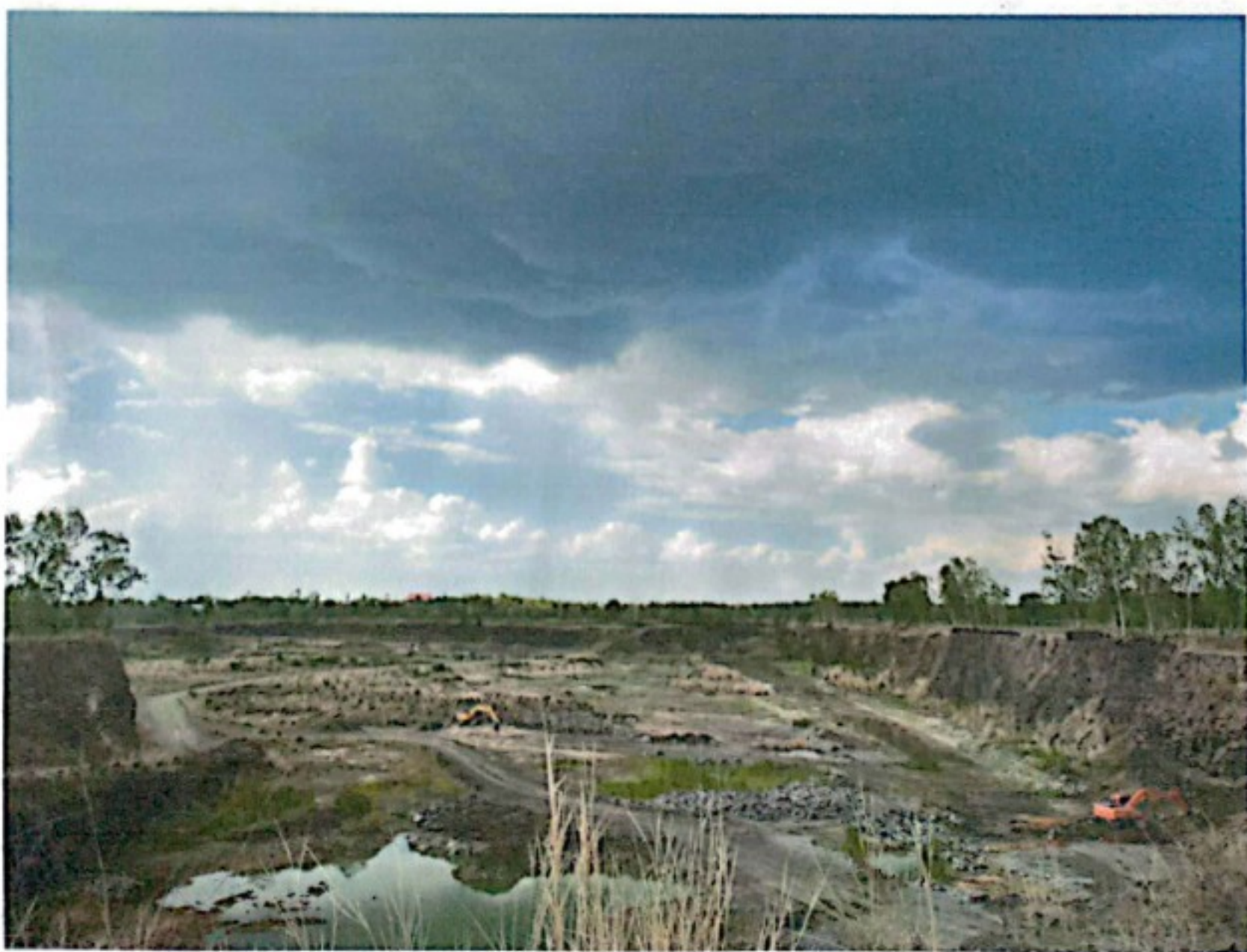
รูปที่ 4 ปรับความลาดชันของหน้าเหมืองพร้อมปลุกต้นไม้รอบบ่อเหมือง
