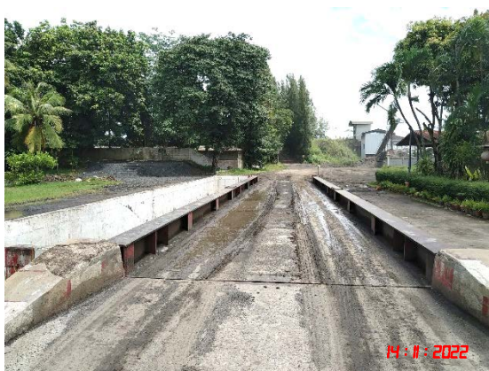
รูปที่ 26 จุดซังน้ำหนักรถบรรทุก
